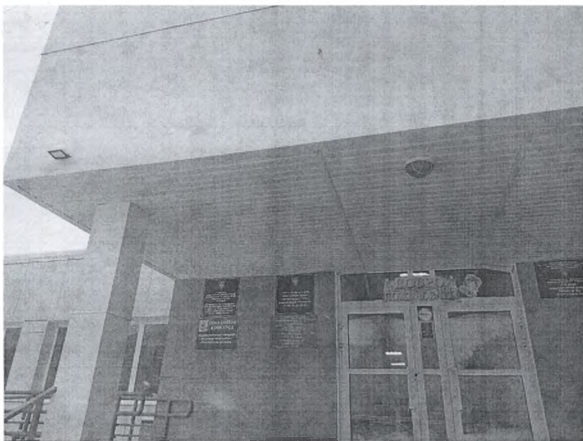
Фото №5. Ремонт навеса и освещение центрального входа.
